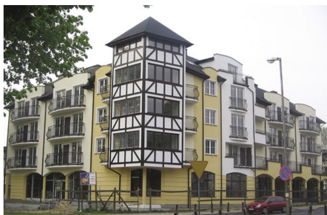
PAWILON MIESZKALNO-HANDLOWY W KOSZALINIE
